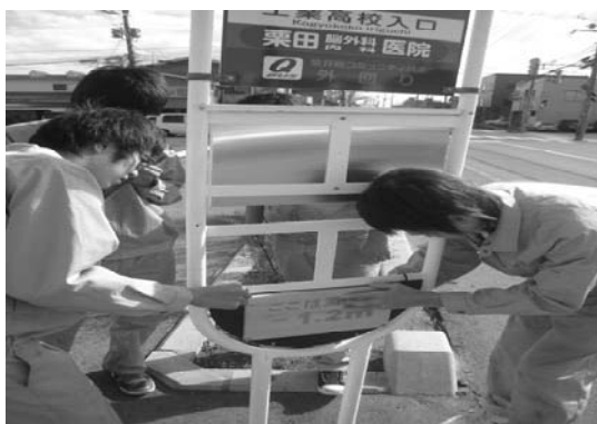
図9．海拔表示プレートの設置
